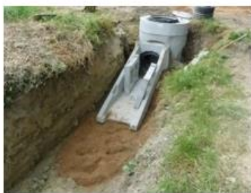
Figure 2 : Aménagement du lit du cours d'eau et conduite eau pluviale
