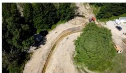
Figure 1 : Clapet ne permettant pas la continuité écologique et rivière de contournement.
