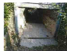
Site de stockage de la Gauteraie à Brain sur Longuenée : rejointement des murs du perthuis
